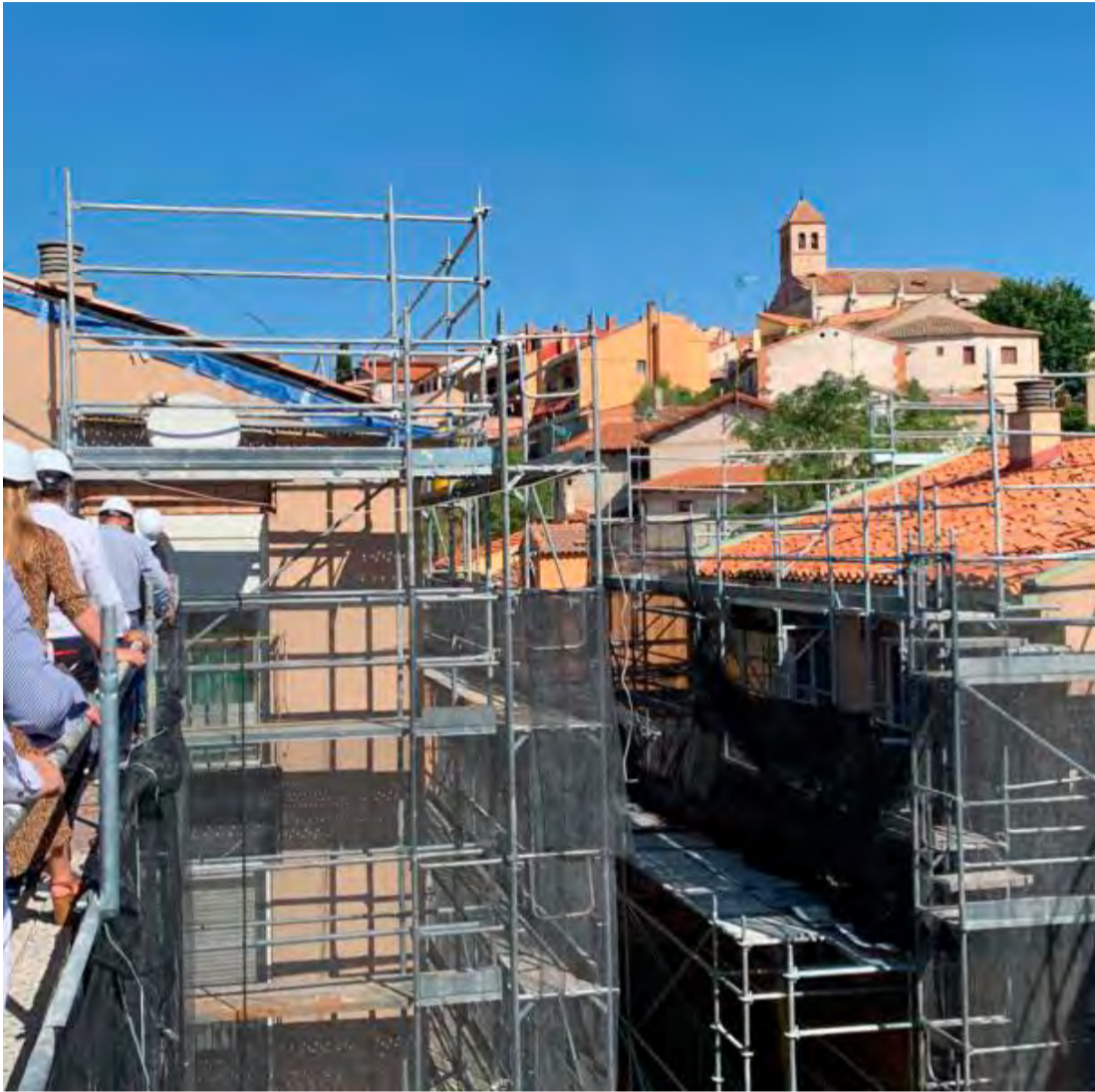
Obras de rehabilitación de viviendas realizadas por la Junta de Castilla y León en Simancas. / ICAL
