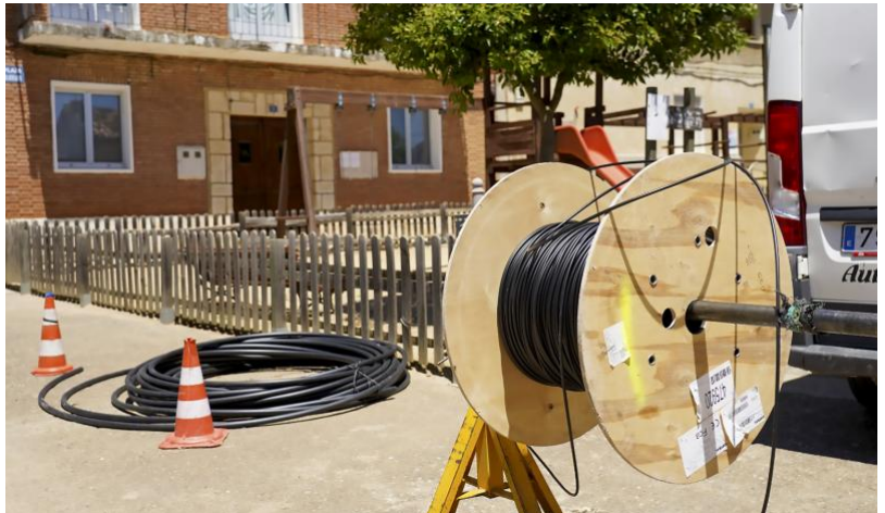
Infiltración de fibra óptica en Barcial de la Loma. / DIP. VALLADOLID
