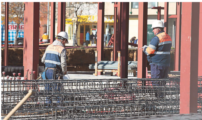
Obras del Conservatorio de Música de León, licitado por la Administración autonómica por 8,46 millones. CAMPILLO / ICAL
