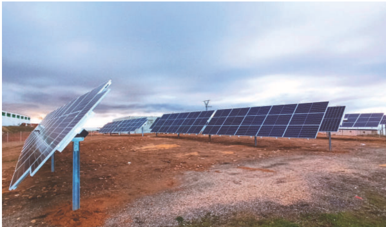
Tecopysa trabaja en proyectos de instalación de plantas fotovoltaicas. / E.M.
